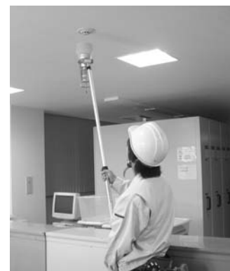
消防設備保守点検
