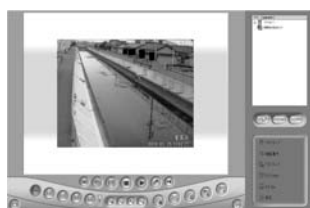
河川・海岸・山林 ネットワーク監視カメラ
