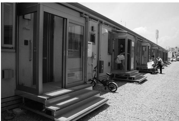
図2 仮設住宅入り口の段差と砂利敷
