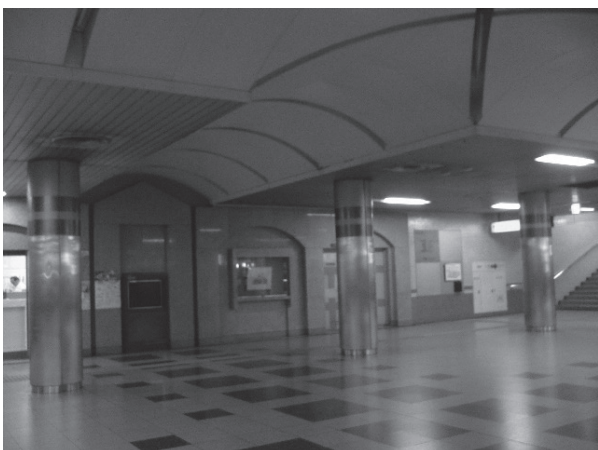
写真3 照明が集中的に消され、「闇溜まり」が生じている事例
