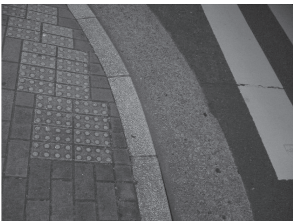
写真10 高圧ナトリウム灯のもとでは、黄色いブロックは明度差で識別可能
