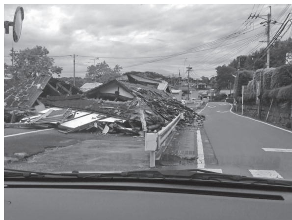
図1 完全に倒壊した民家：益城町 (4月26日 中村透撮影)
